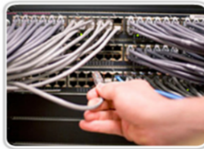
Conexiones RJ-45
